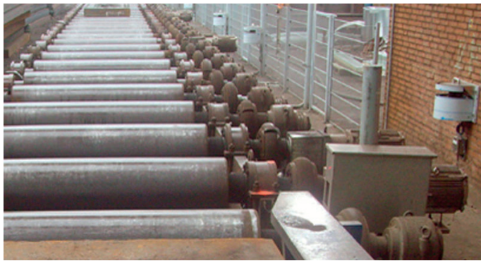
Brammenverfolgung am Rollgang
